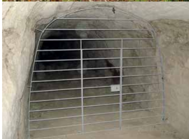
Protection cavités à chauves-souris. LPO Anjou
